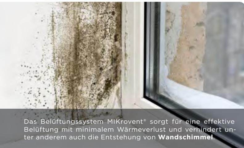
Das Belüftungssystem MIKrovent® sorgt für eine effektive Belüftung mit minimalem Wärmeverlust und verhindert unter anderem auch die Entstehung von **Wandschimmel**.
